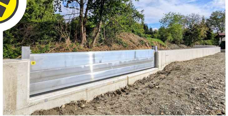
Linearer Hochwasserschutzverbau - Zufahrt
